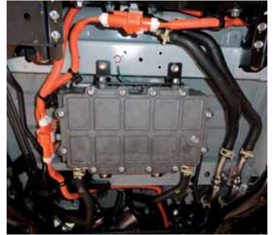
Acceso a la batería
